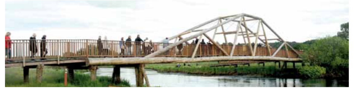
Kjællinghøl-broen over Gudenåen er Danmarks længste bro udført i rundtømmer. Broen har et frit spænd på 35 meter.
